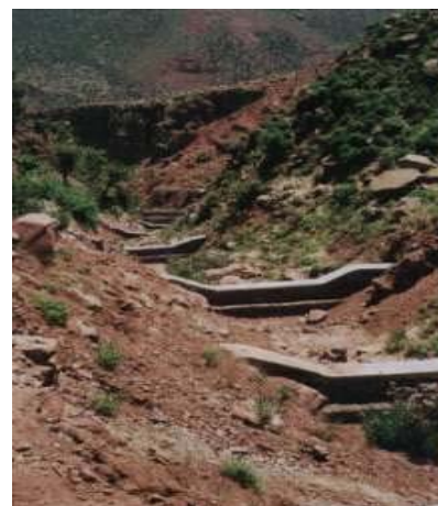
Photo n° 13: Lutte contre l'érosion hydrique: Seuils de sédimentation
